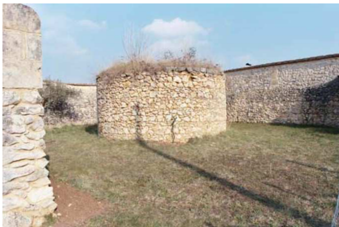
Fondations du Moulin de Poujeau
