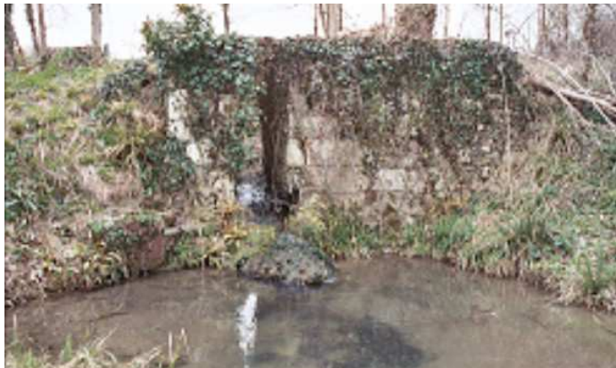
Retenue d'eau du Moulin de Canterane
