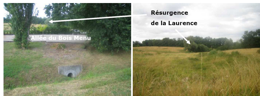
La Laurence, de nouveau busée pour passer sous l'allée du Bois Menu. Elle retrouve un cours aérien dans le champ voisin (droite)
