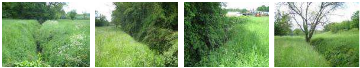
Etat des ripisylves du Fargues dans sa partie amont proche de la station d'épuration
