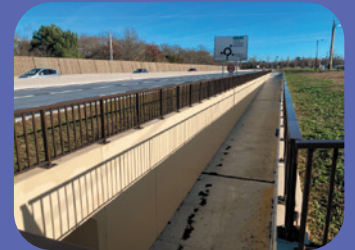
Passage intérieur Le colinet Accès PMR
