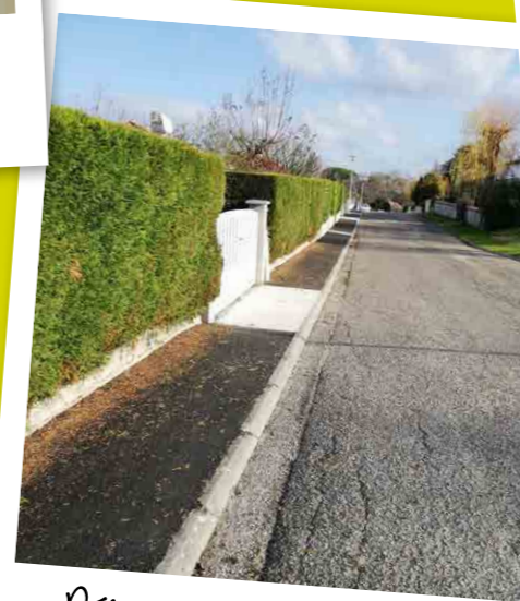
Réfection des trottoirs du Vallon COÛT DES TRAVAUX : 14 900 €
